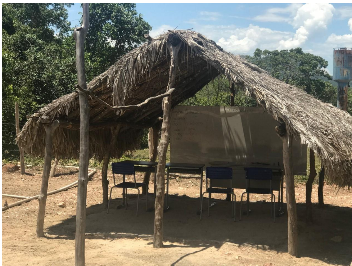
Figura 14: Deficiência no espaço físico: sala de aula improvisada
