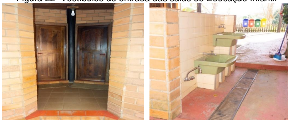
Figura 22- Vestíbulos de entrada das salas de Educação Infantil
