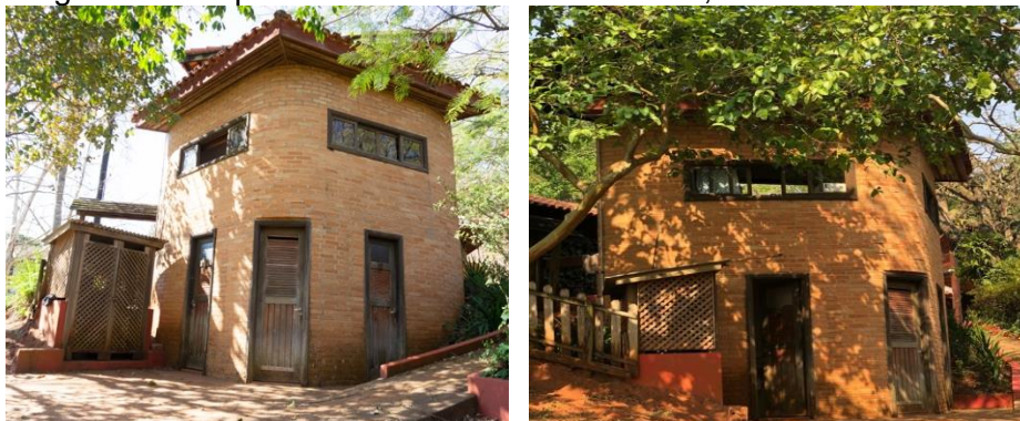
Figura 23 - Depósito e dois banheiros externos, embaixo da cozinha
