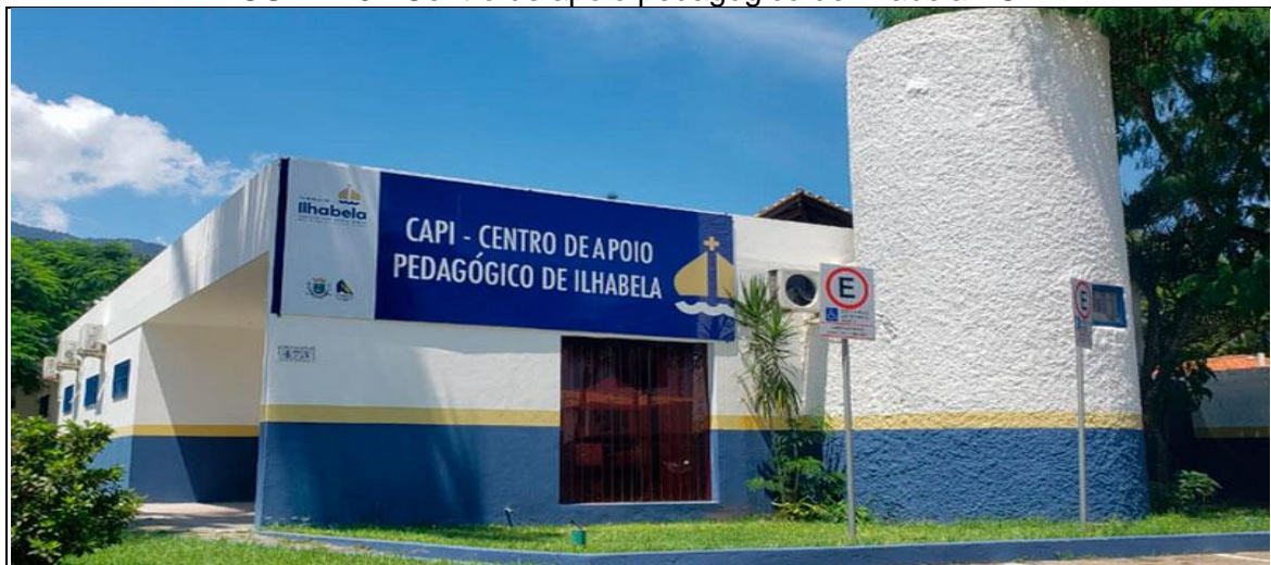
FIGURA 19 - Centro de apoio pedagógico de Ilhabela - CAPI
